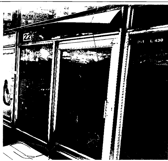
Día de visita: 01 de octubre de 2019 Contenedor No. 22 costado noroccidental cerrado y no inspeccionado
